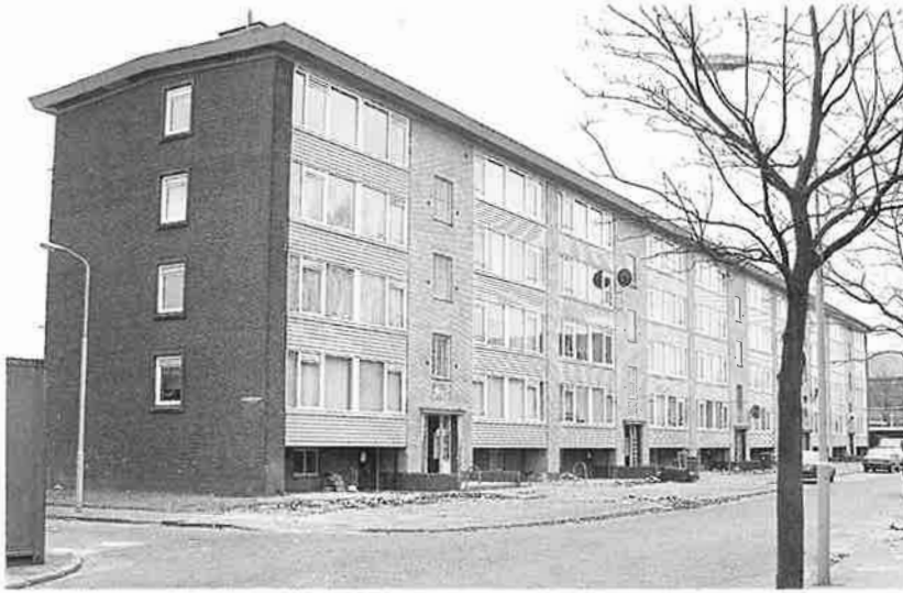
De flats aan de Ingenhouszstraat tijdens de renovatie in 1996. De tableaus zijn nog goed zichtbaar: (foto R.C. van Lieshout, Chr. Verwey, collectie HKH)
